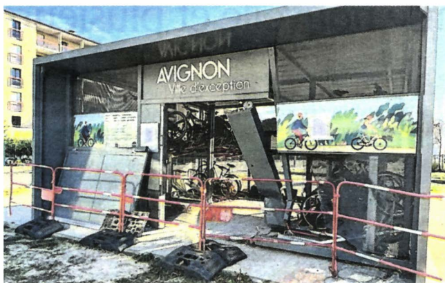
Certains vélos stationnés dans le garage sécurisé porte Saint-Lazare ont été endommagés par un véhicule, dont le
